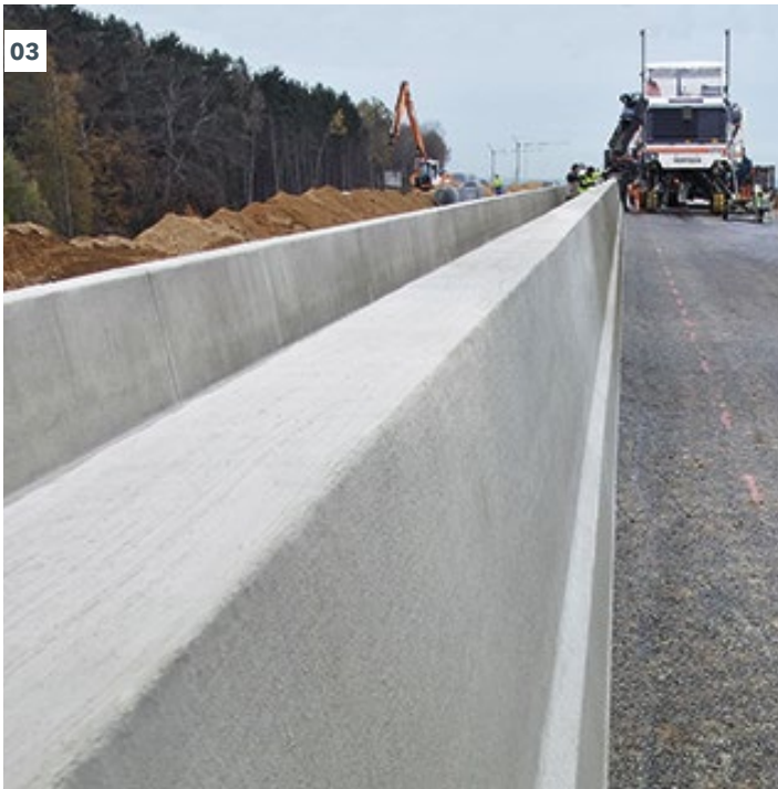
03 - 04 O excelente sistema de comando da máquina garante precisão tanto nas retas quanto nas curvas.
