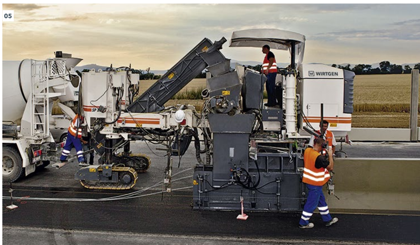
04 - 05 O molde deslizante pode ser montado à direita ou à esquerda: a mudança de lado é feita muito rapidamente.
