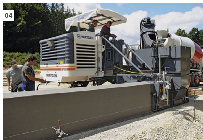
04 - 05 O molde deslizante pode ser montado à direita ou à esquerda: a mudança de lado é feita muito rapidamente.
