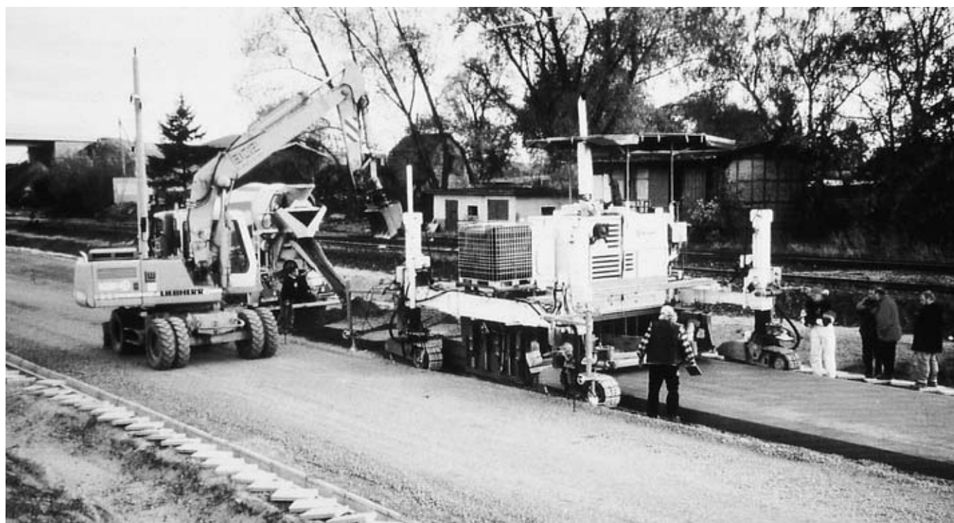
Leonhard Weiss の SP500 でカント 145mm 及び 30mm のリーコンクリートベースコースの 1 レーンを施工。
