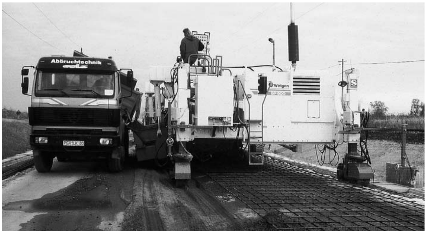
コンクリートが供給された時はコンベアベルトは機械の中に引き込まれているのでトラックが通過する事が出来る。
