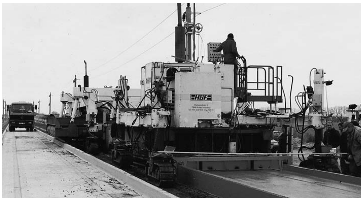
この写真はサイドフィーダーと SP850 スリップフォームペーパーで構成されている一連の二次舗設機械。片方の RHEDA トラフは既に完成している。コンクリート搬送のトラックが完成されたトラフの上にいる。現場の特殊事情によりコンクリート搬送のトラックは舗設作業の方向と反対の方向に走行している。
