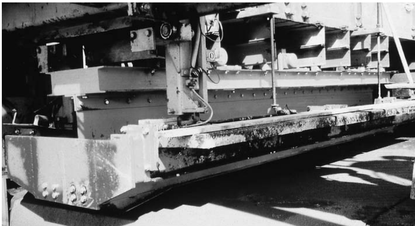
ダウエルバー挿入機の振動フレームとフォークを振動ブレードに交換し、ダウエルバーを挿入する時と同じ方法でフレッシュリーコンクリートベースコースに横断ジョイントの目地切りをした。
