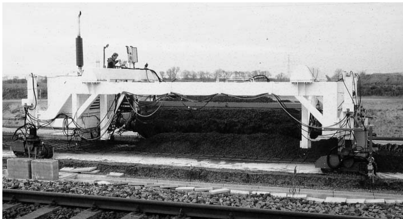
コンクリートを約7.00mの長さ（コンベアベルトの幅と同じ）で移送。
