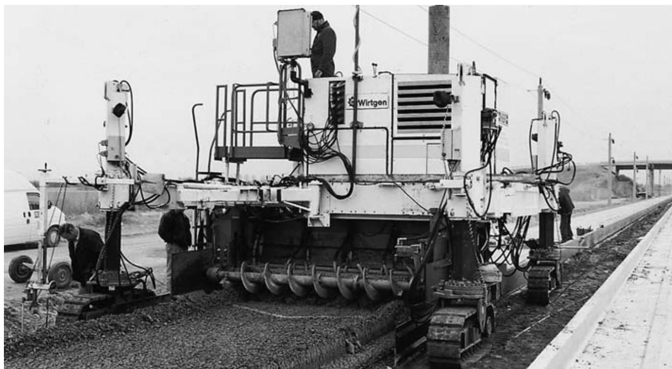
コンクリートが側壁帯に両サイドに多く散布されている SP500 の前方光景。
