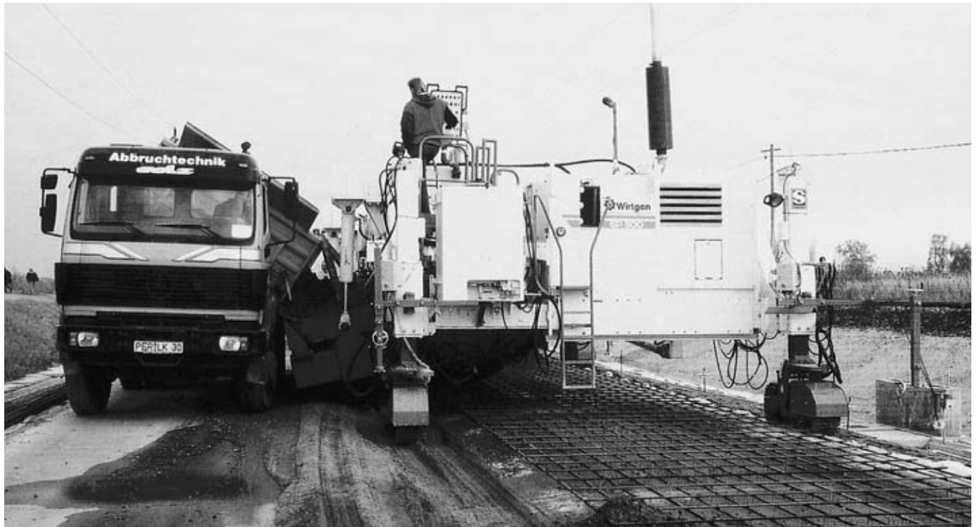
前方より見た、コンクリートをトラックよりサイドフィーダーへ供給している光景。 トラックの進行方向は工事の進行方向と同じ。
