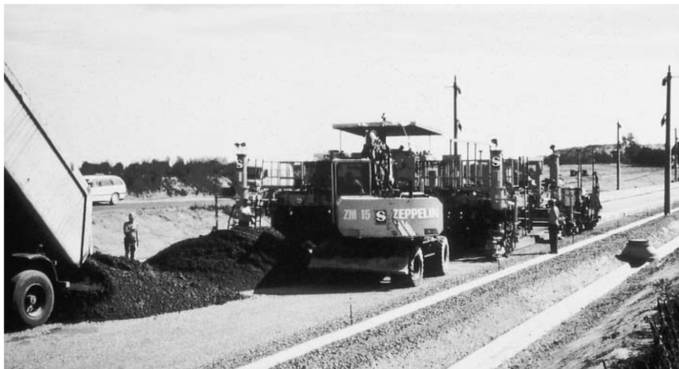
リーコンクリートベースコースの材料が舗装幅員 8.5m の機械に供給されている。
