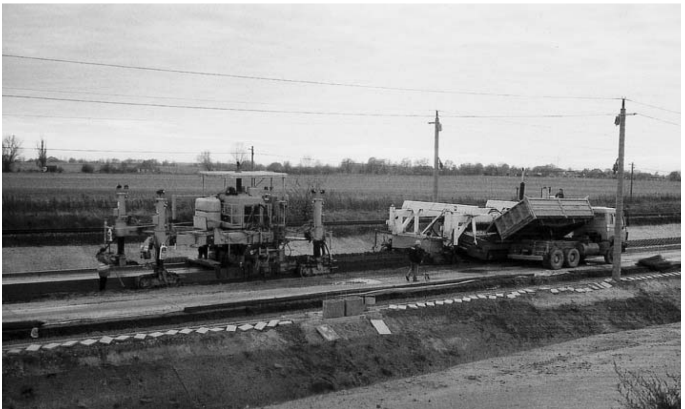
舗設機械の1台とサイドフューダー
