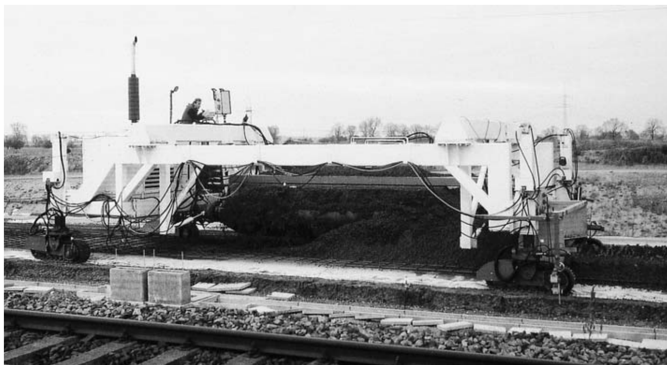
トラックは 8cu.m のコンクリートを搬送出来る。概略 5cu.m のコンクリートが直線距離 7.00m のスラブ舗設に要求されるのでサイドフィーダーはあとの 3cu.m のコンクリートを散在するために移動する。
