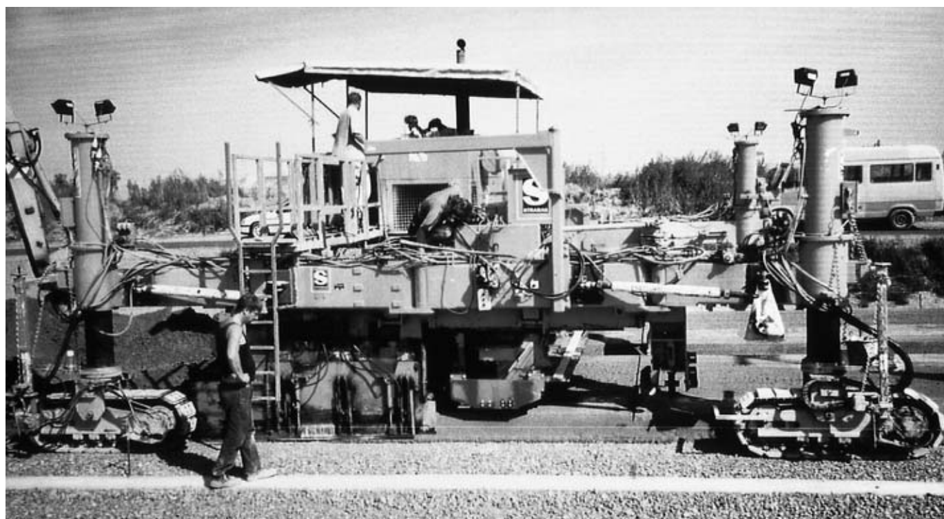
装備されているダウエルバー挿入機を改造して 5m 幅の間隔でリーコンクリートベースコースの片々のレーンの目地切りが出来る様にした。
